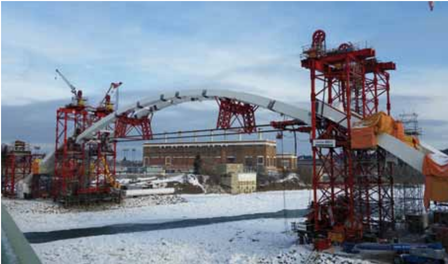
Manobra de izado de parte central
