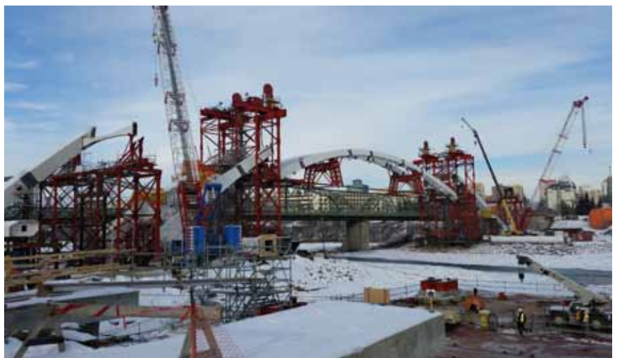
Manobra de izado de parte central
