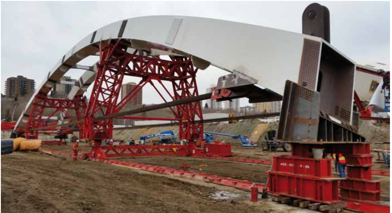
Toma de carga con los skidshoes en playa de lanzamiento
