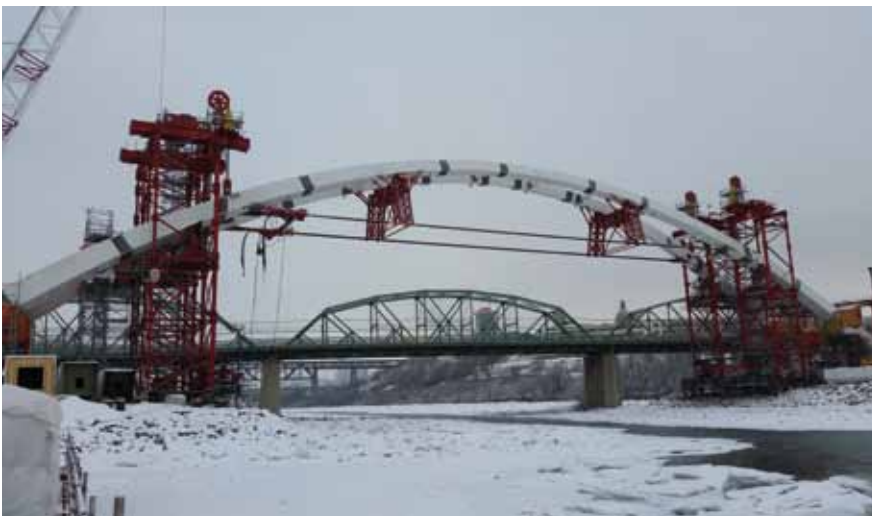
Posición final del ensamblaje del arco central
