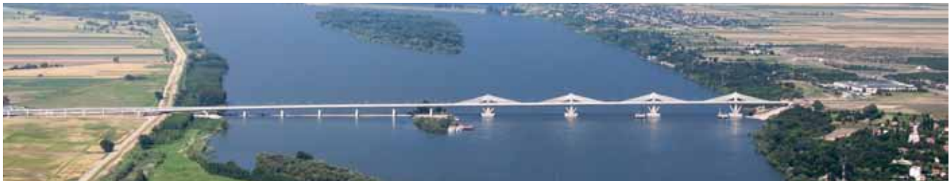
Vista del puente aguas abajo
