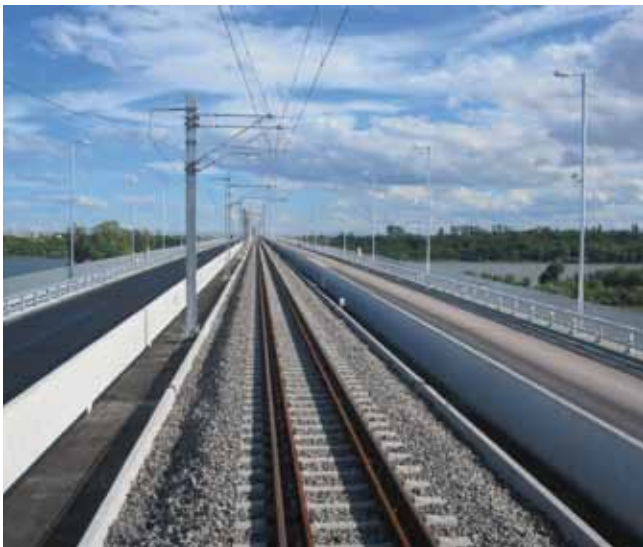
Vías entre calzadas
