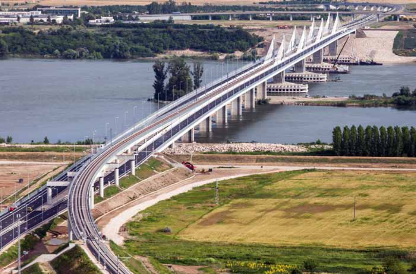
Puente sobre el danubio. Obra acabada
