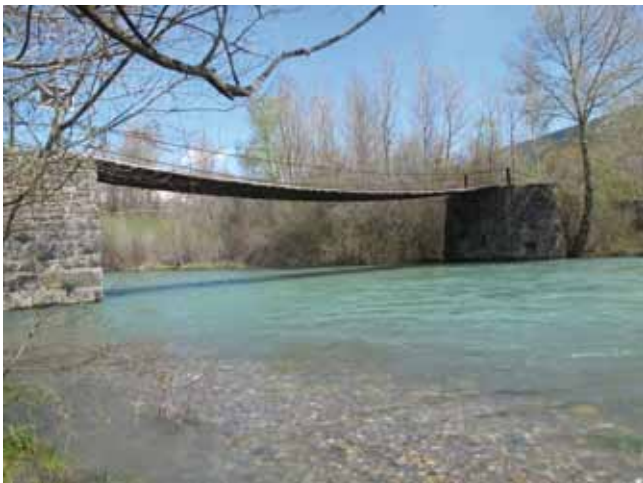
Fig. 4. Puente de las Pilas sobre el río Gállego
