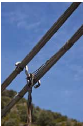
Fig. 9. Péndola con su fijación a los cables principales y al tablero
