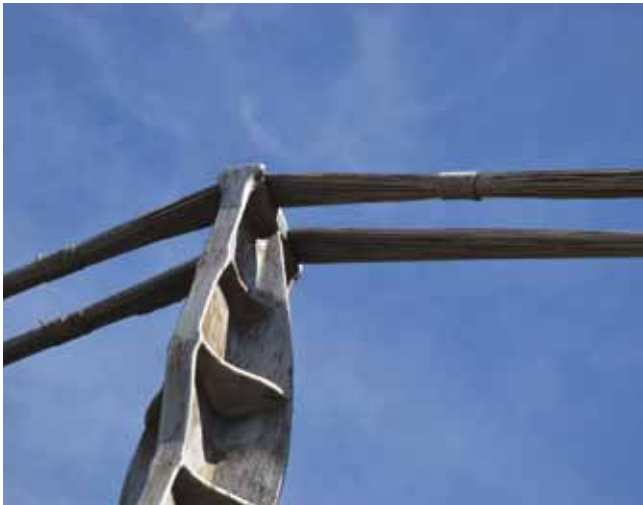
Fig. 8. El paso por las sillas de los cables principales
