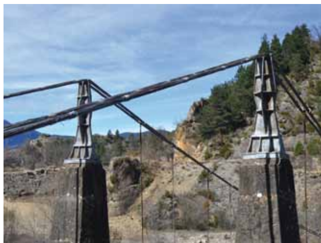
Fig. 11. Piezas de fundición de las torres
