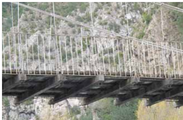
Fig. 12. El tablero de madera
