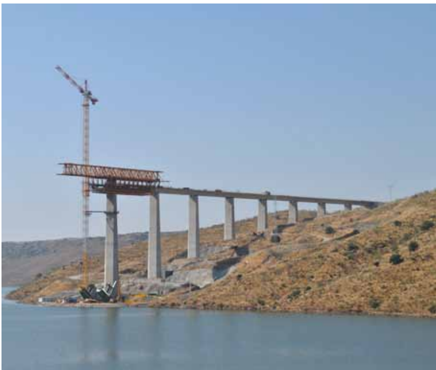
Vanos de acceso al tablero
