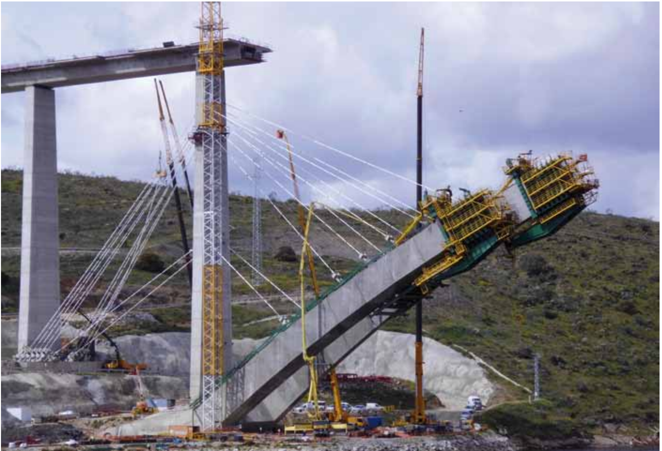
Tirantes del viaducto
