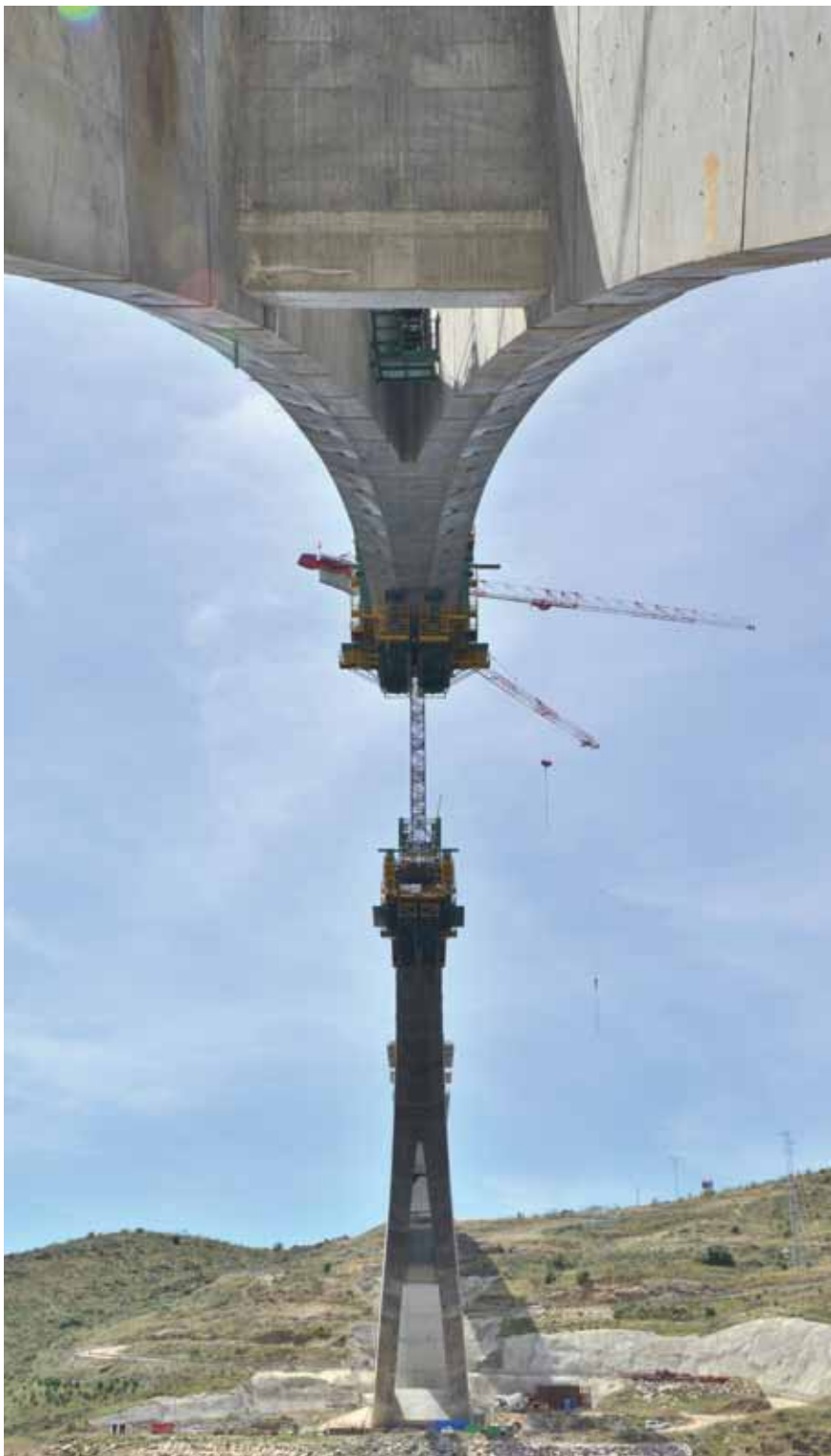
Vista inferior del viaducto
