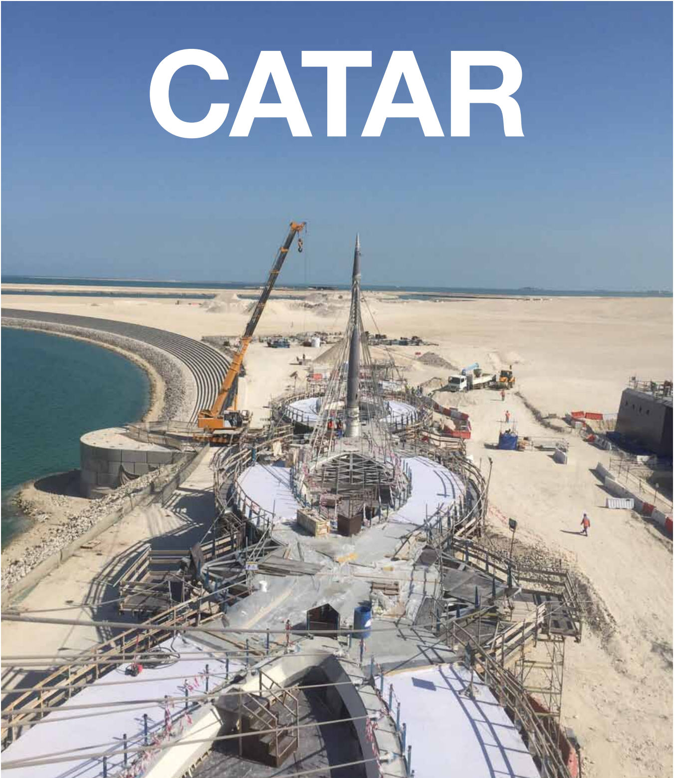
Pasarelas peatonales en Catar (FCC)
