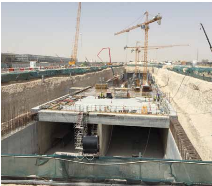
Estación Education City del Metro de Doha (OHL)
