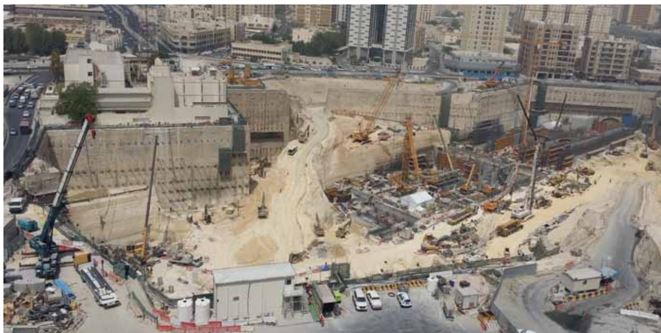
Estación Msheireb del Metro de Doha (OHL)
