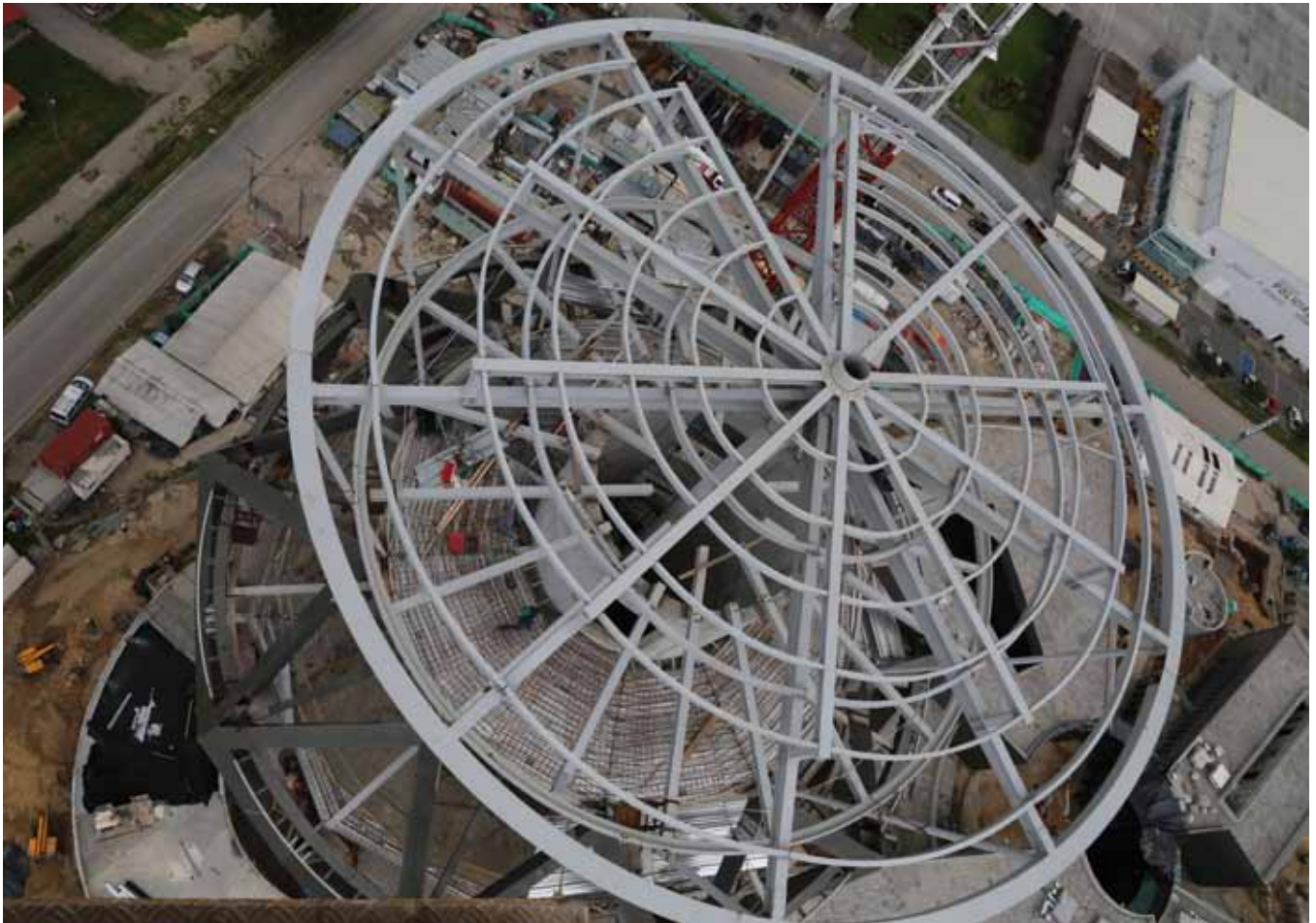
Vista cenital de la torre
