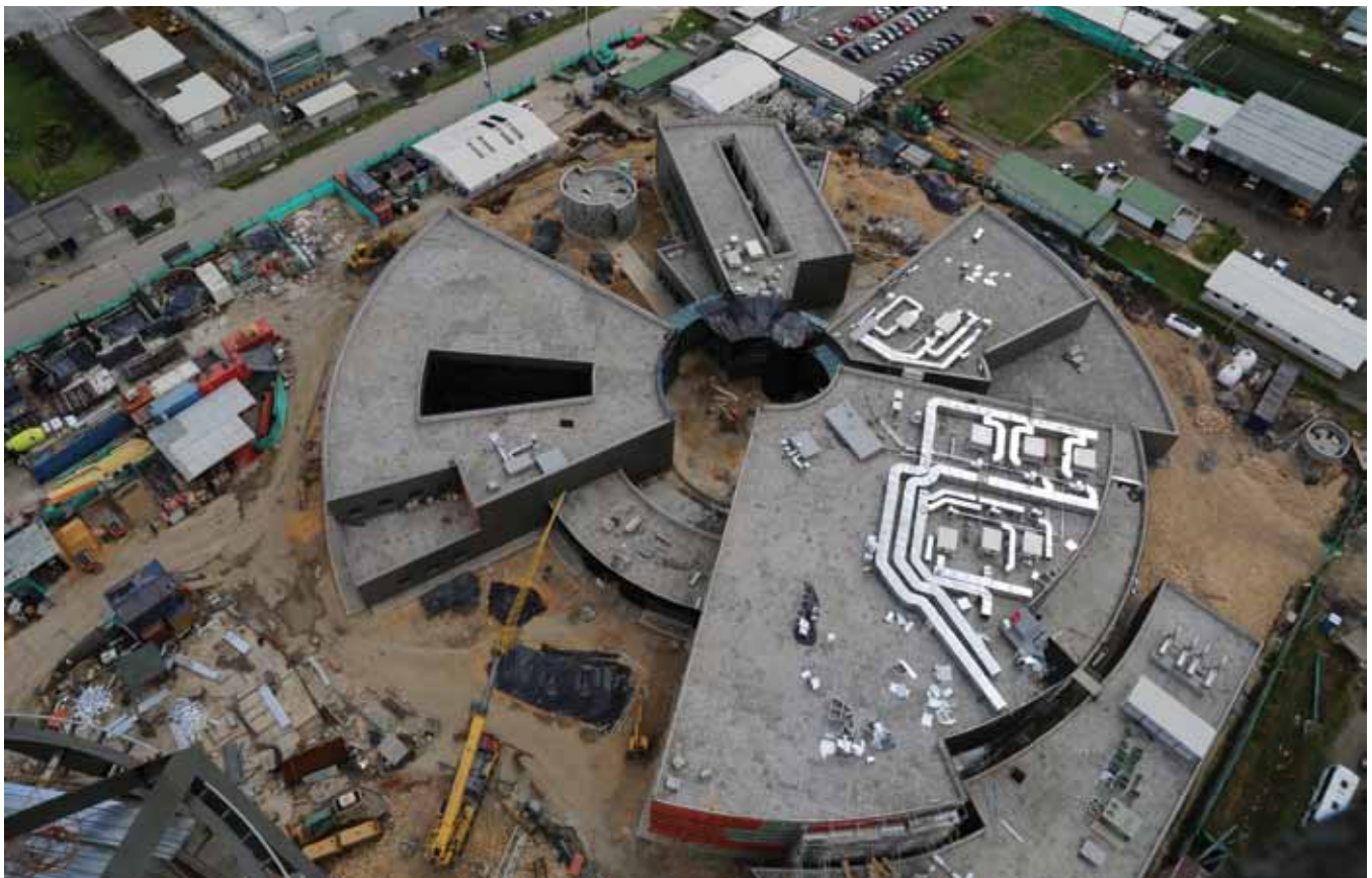
Trabajos de construcción
