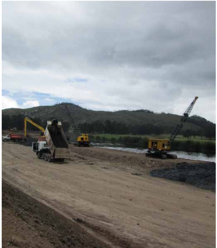
Ampliación del cauce del río
