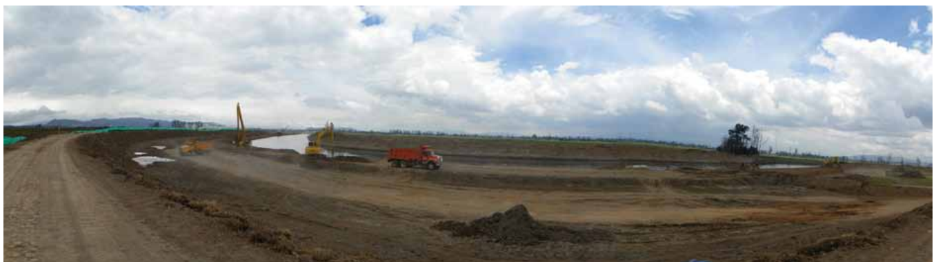
Realización de trabajos que se prolongarán hasta 2015
