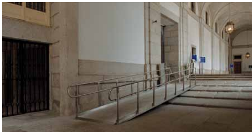
Rampa y plataforma elevadora que salvan las escaleras de acceso al Patio de Coches
