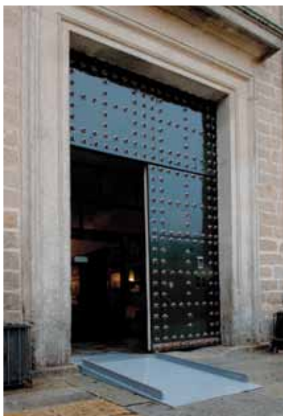
Rampa de acceso
