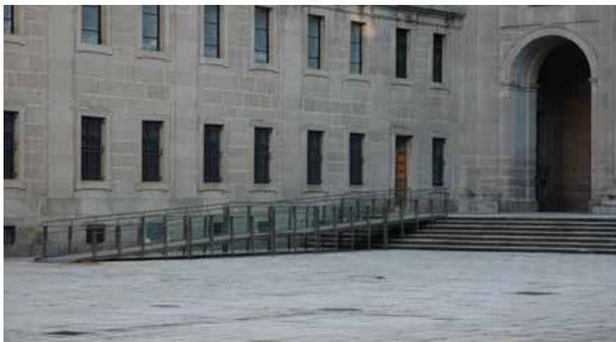
Rampa de acceso a la Basílica desde el Patio de Reyes
