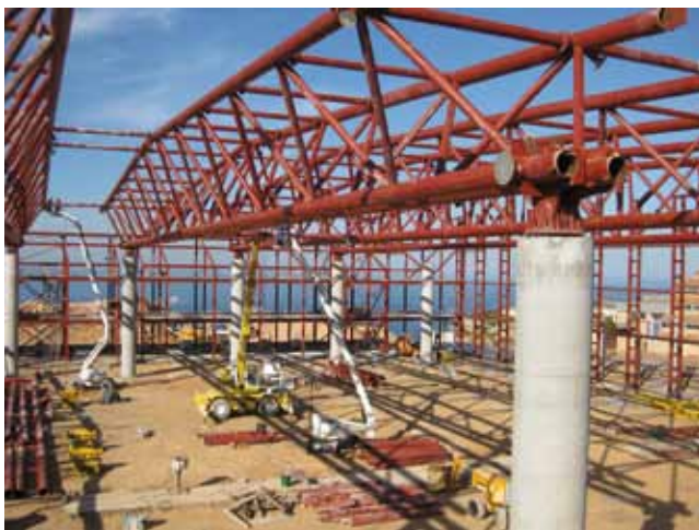
Estructura del Palacio de Exposiciones
