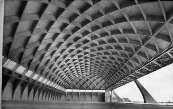
Fig. 40. Hangar de Orvieto. Italia. 1935. Pier Luigi Nervi.
