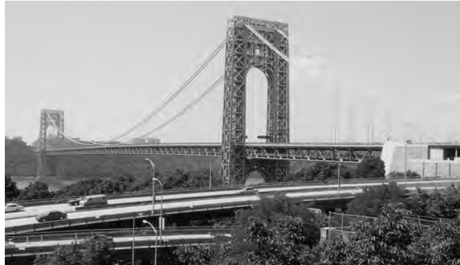
Fig. 29. Puente de Alejandro III sobre el Sena en París. 1901. J. Resal Ing. Cassien-Bernard y Caussin Arqs. Luz 107 m. Fig. 30. Puente de George Washington sobre el río Hudson. Nueva York 1931. O. Ammann Ing. C. Gilbert Arq. Luz 1067 m.
