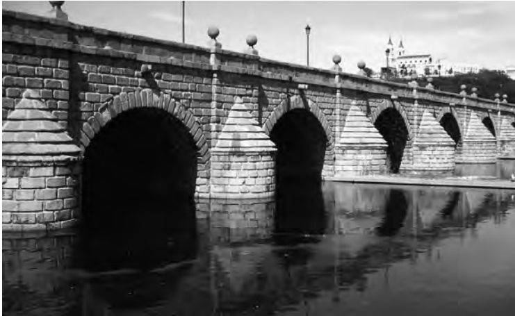
Fig. 12. Puente de Segovia en Madrid sobre el río Manzanares. Juan de Herrera. 1589. Fig. 13. Puente de Torrelodones sobre el río Guadarrama. Juan de Herrera.
