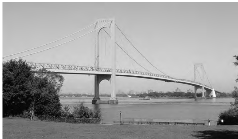
Fig. 31. Puente de Bronx-Whitestone en Nueva York. 1939. O. Ammann Ing. A. Embury Arq. Luz 701 m.
