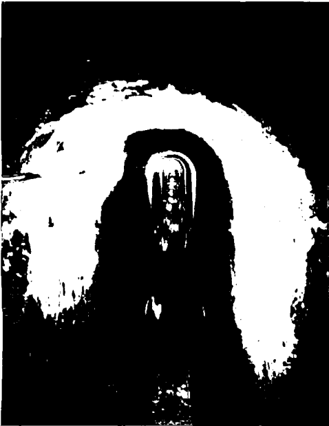
Fig. 5. La galería principal de transporte, de amplias dimensiones, conduce las aguas de manera independiente en función de su calidad: las más duras por la canaleta izquierda y las más blandas por la de la derecha. A la dcha, fig. 6. Los pozos de aireación, espaciados regularmente a lo largo de las galerías, que sirven para acceder a la zona de trabajo y la extracción de materiales al exterior, están revestidos de piedra o ladrillo hábilmente labrados.
