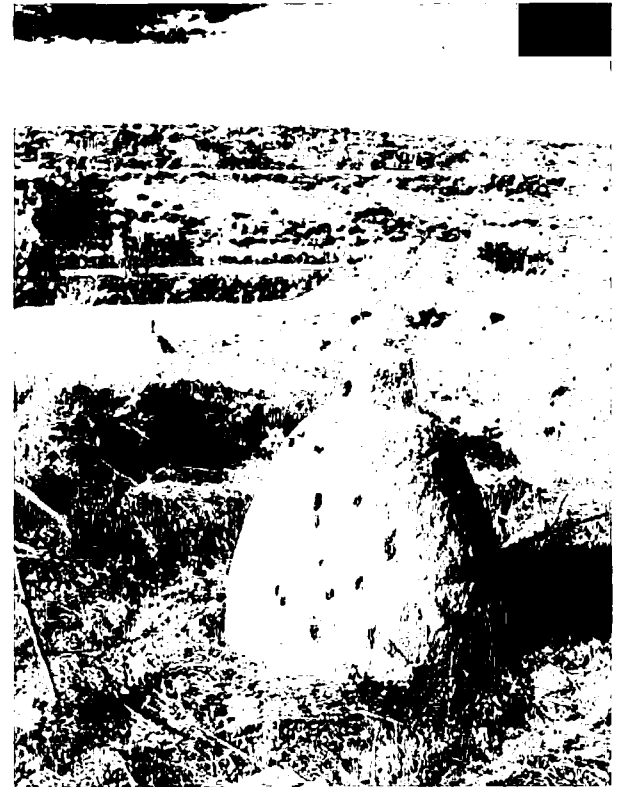
Fig. 7. El remate exterior de los pozos de aireación es una especie de capirote, con varios taladros en su extremo, que sirven como respiraderos, se denominan localmente "madamas". En Madrid se llaman "capirotes".
