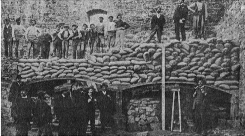
Fig. 3. Prueba de dos bóvedas para el depósito de Gijón. Publicada en "El Cemento Armado" y en la R.O.P. / Test of two arches for the Gijon water tank. Published in "El Cemento Armado" and the R.O.P.
