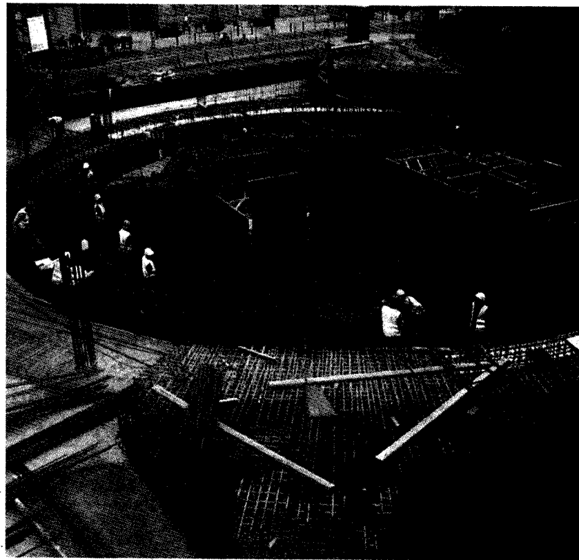
Fig. 6. Ferrallado losa superior del pozo en la estación de Llofià.
