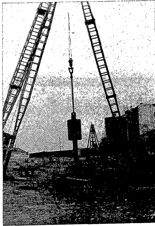
Fig. 2.—Martinete y columna del penetrómetro pesado (fot. Pilson, S. A.).
