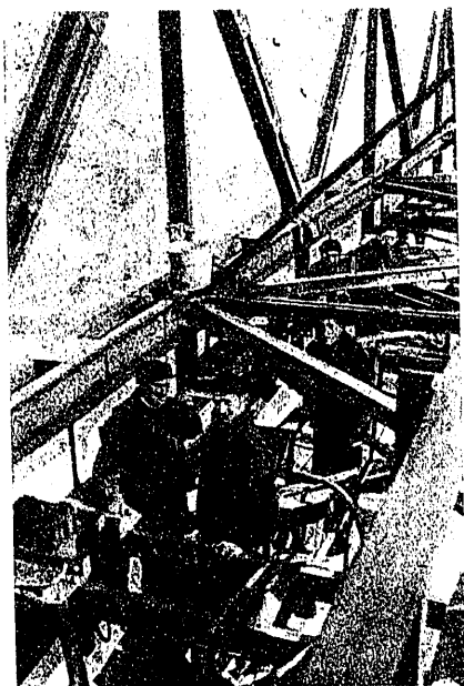
Fig. 2. — Roblonando la viga.
