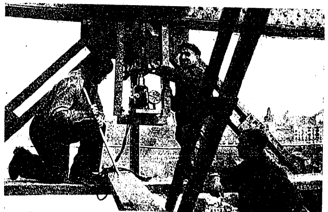
Fig. 5.—Aparato de tensado de péndolas.
