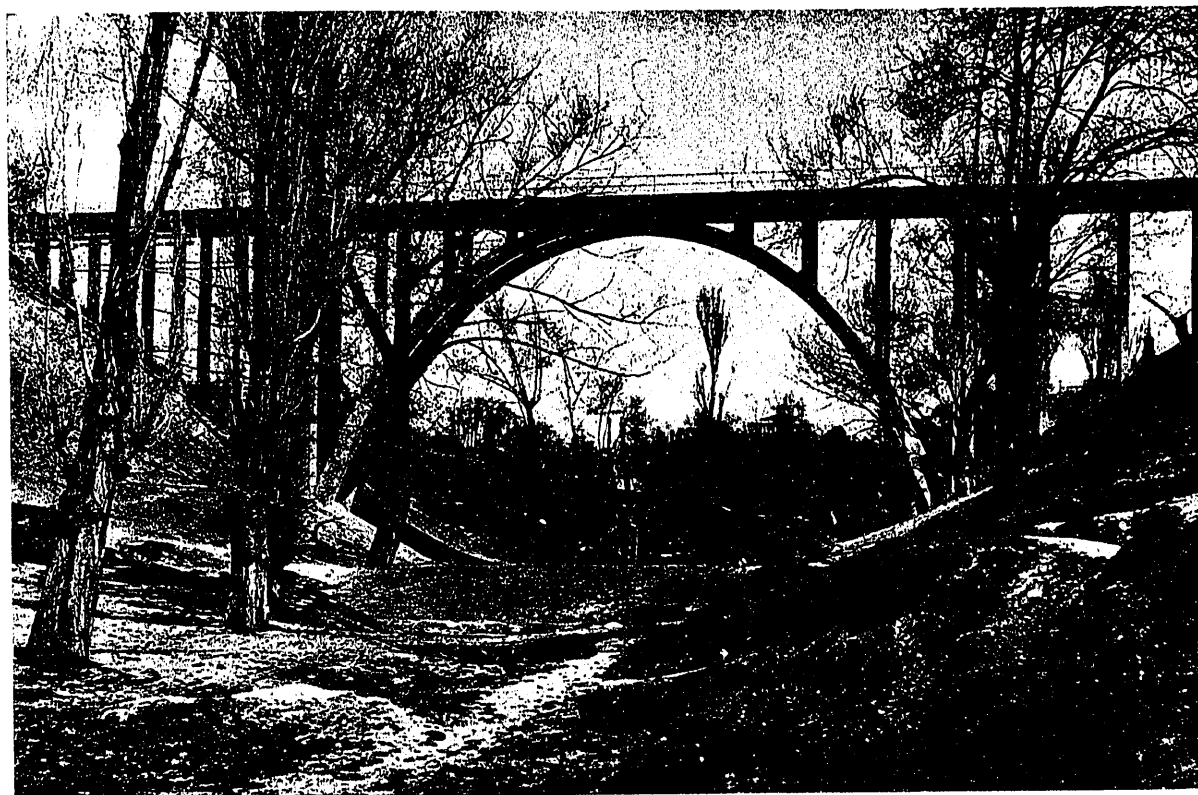
Viaducto del aire. Vista lateral.
