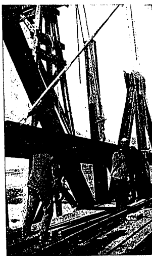
Fig. 3.ª Montaje de la cabeza superior de una viga principal del tramo 2.º.
