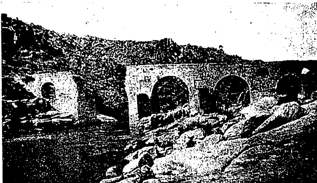
Fig. 9.ª Puente del Conde.—Vista general.
