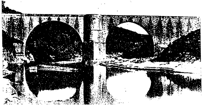
Fig. 4.ª Puente de Almaraz.—Frente de agua abajo.
