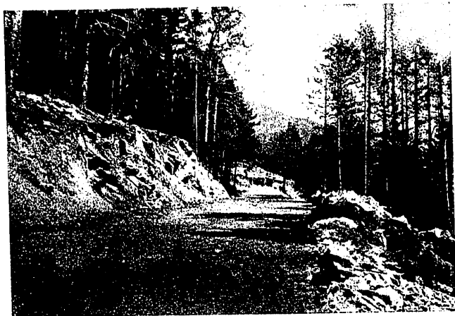
La explanación antes del asiento de la vía.
