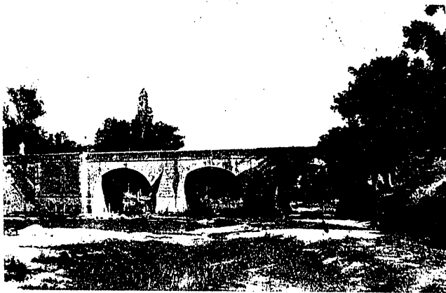
Puente de San Fernando. Tramo de la derecha.
