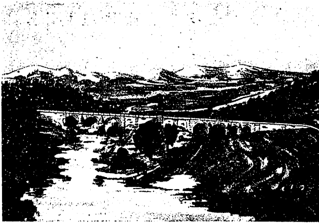
Puente de San Fernando. Vista general. (Dibujo de Silverio de la Torre).
