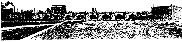
Puente de Toledo. Vista general.
