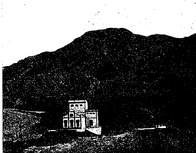
Casa de máquinas y vista general del salto
