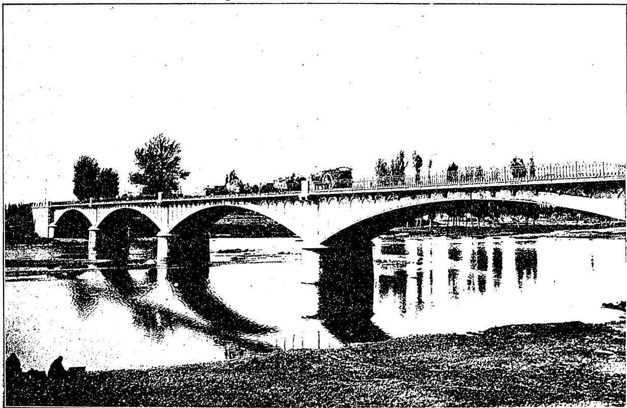
Vista general del puente terminado.
